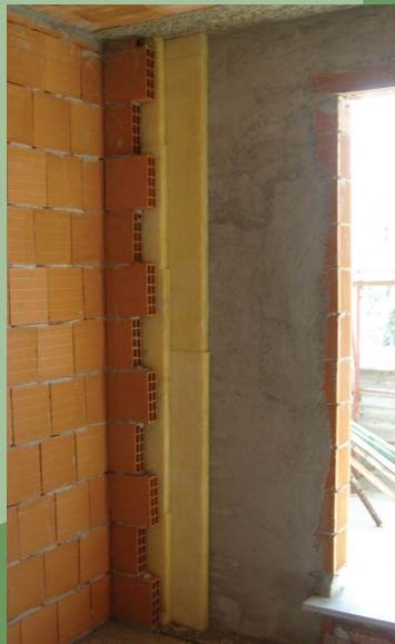
Isolamento in lana di vetro da 10 cm (5 cm+5 cm).
